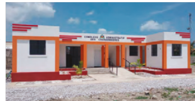
Le nouveau bâtiment de la Mairie de Chardonnières (détruite par le séisme d'août 2021), priorisé et reconstruit par les acteurs communaux en 2022-23 dans le cadre du dispositif FIL. © ID
