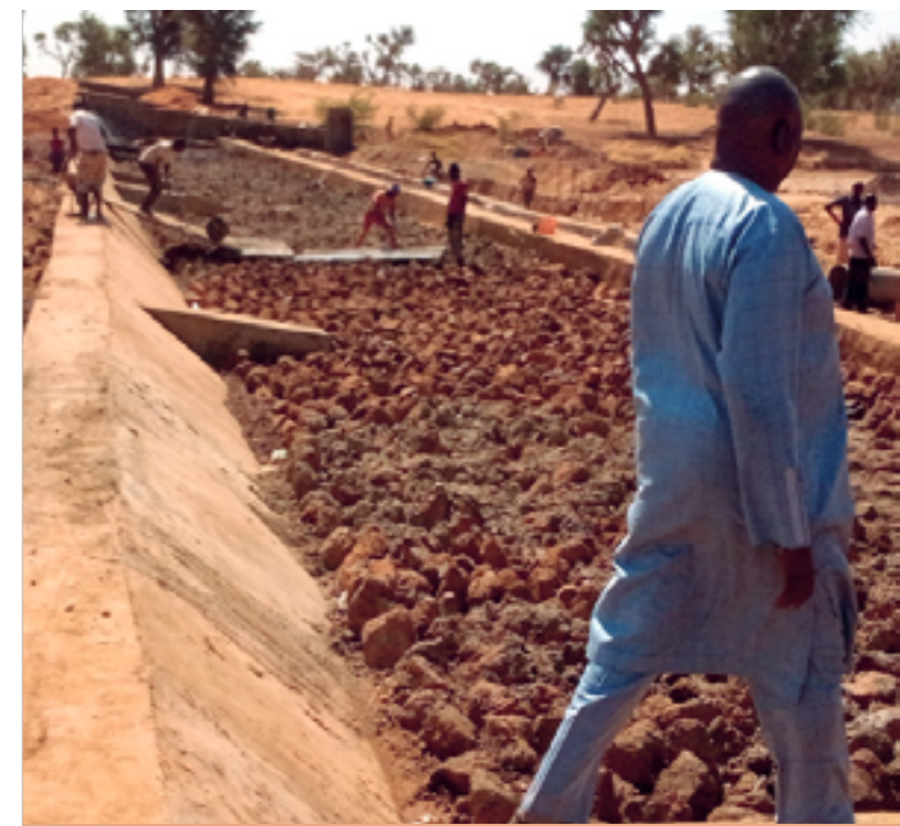
Seuil dépendage en construction dans la commune rurale de Tamaske département de Keita, région de Tahoua. © Projet Pôles Ruraux
