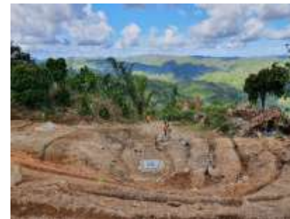
Aire de captage du chantier d'envergure de Vohipeno (région Analanjirofo)
