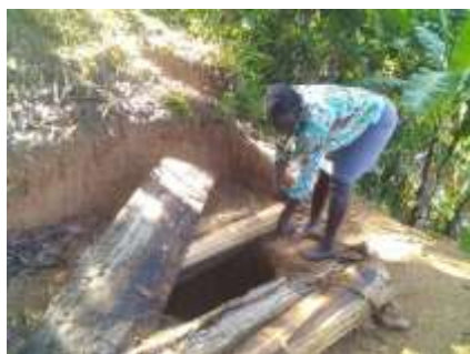
Vérification de la profondeur de la latrine
