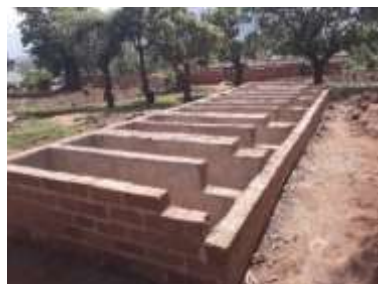
Construction de latrines avec fosses dans une école primaire à Phalombe
