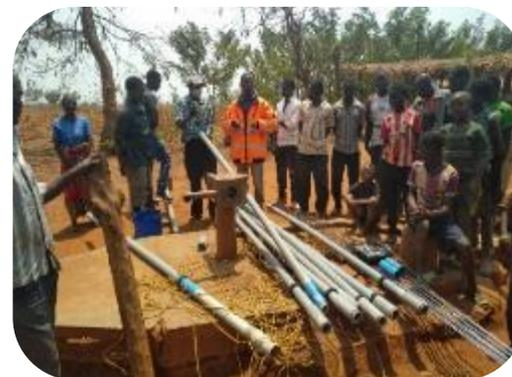
Réparation complexe d'une pompe équipant un point d'eau.
