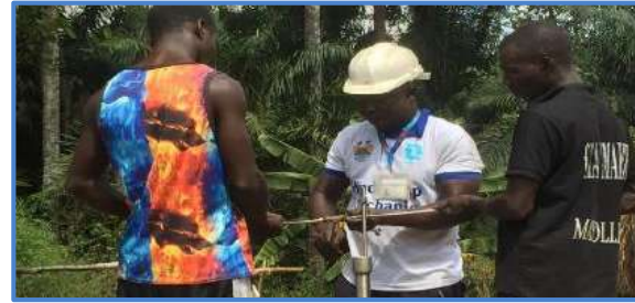
Réparateur formé par Inter Aide démontant une pompe
