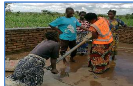
Entretien d'une pompe de type Afridev par une réparatrice formée par Inter Aide
