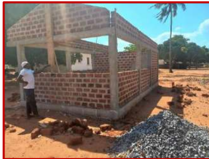
Construction d'un abri pour les patients à Caleia, mené par le comité de cogestion
