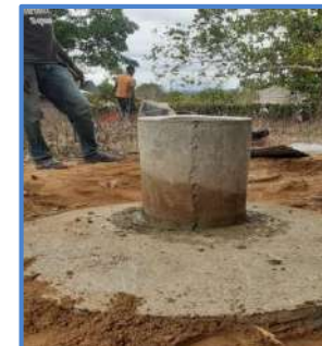
Formation des maçons pour la fabrication d'un siège de latrine
