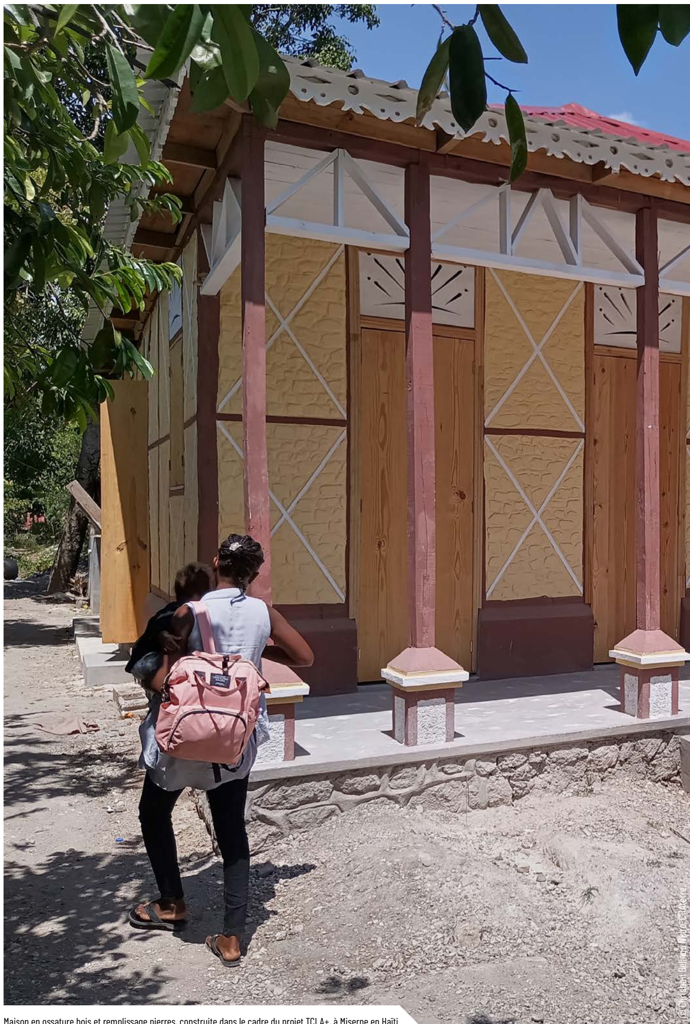
Maison en ossature bois et remplissage pierres, construite dans le cadre du projet TCL+ , à Miserné en Haïti.
