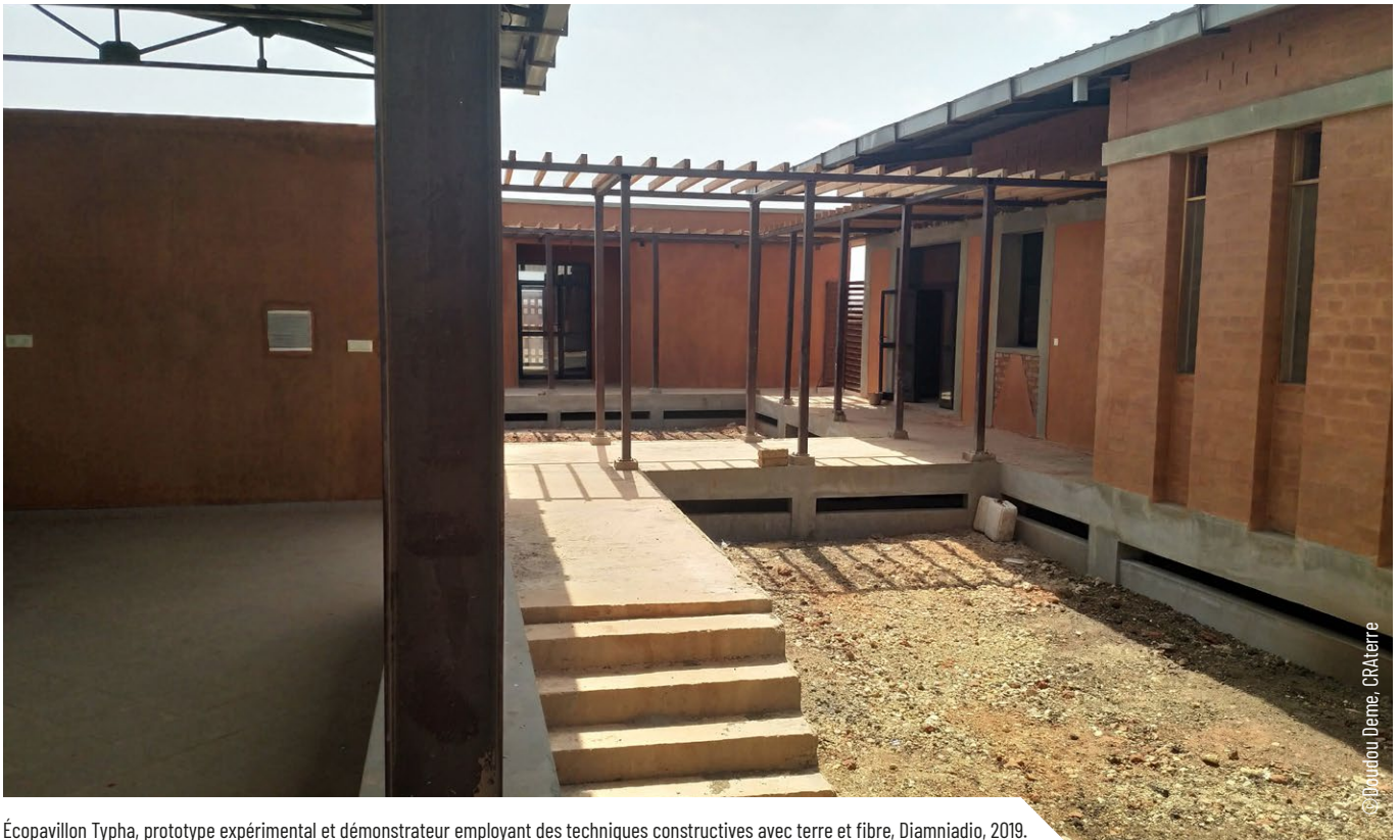
Écopavillon Typha, prototype expérimental et démonstrateur employant des techniques constructives avec terre et fibre, Diamniadio, 2019.
