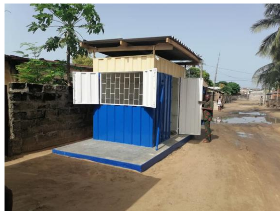
Photo 5. Kiosque installé à proximité d'une borne fontaine
