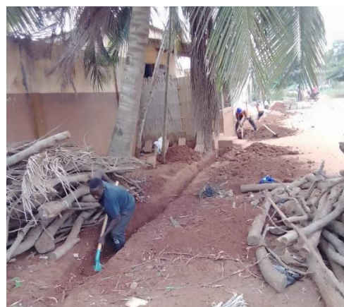
Photo 8. Travaux de pose d'extension de réseau
