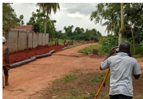
Photo 6. Travaux d'interconnexion des sous-réseaux Anfoin et Aného
