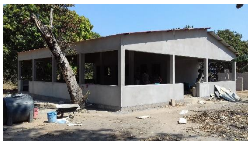
Bâtiment de consultations externes en construction à Chipene (district de Momba)
