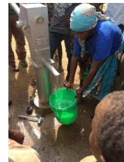
L'installation de la pompe est toujours un moment important
