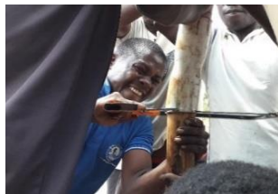
Un artisan en plein effort pour réparer le tuyau d'un forage
