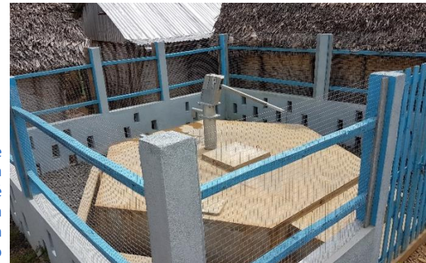
Puits équipé de pompe à motricité humaine dans la région Analanjirofo
