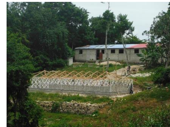
Chantier de l'école communautaire de Lexis
