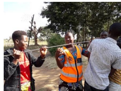
Réparation en cours par l'une des mécaniciennes du réseau
