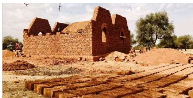
Réalisation de voûte nubienne au Sénégal - © Le Partenariat
